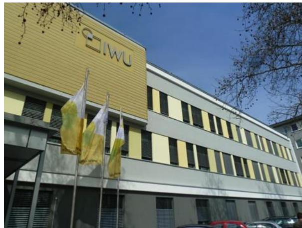
Abbildung 2 Gebäude nach der Modernisierung, Quelle: IWU
