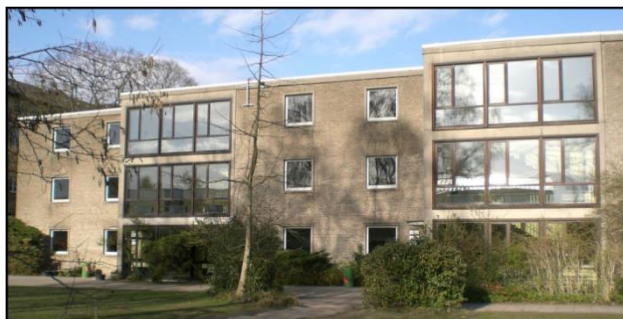
Abbildung 1 Südwestansicht vor der Sanierung [1]
