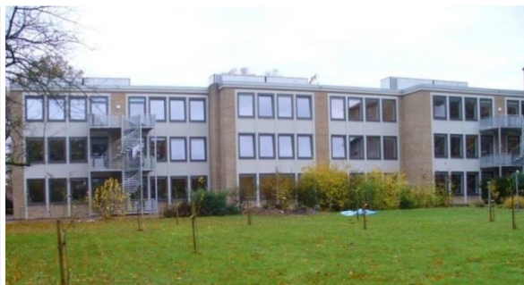
Abbildung 2 Nordansicht nach der Sanierung [1]
