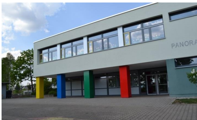
Abbildung 1 Gebäude nach der Sanierung, Quelle: KEA
