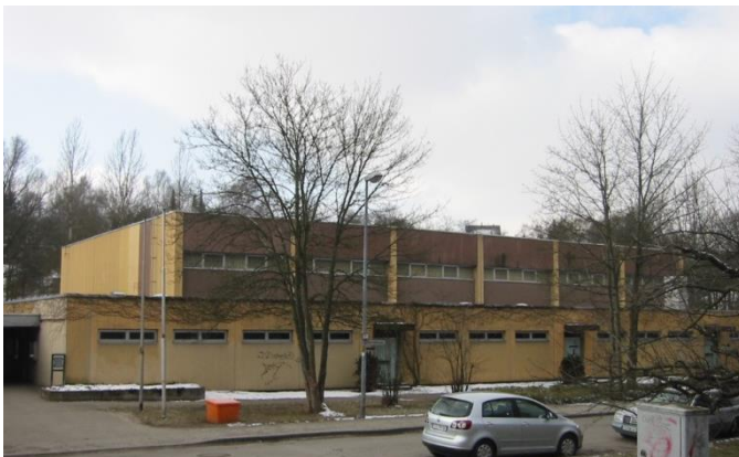
Abbildung 1 Gebäude vor der Modernisierung, Quelle: Stadt Ostfildern
